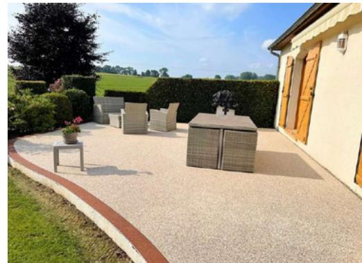
Ce revêtement souple peut être coulé sur plusieurs supports existants. Il est **drainant, sans raccord** et **résiste aux UV**.
